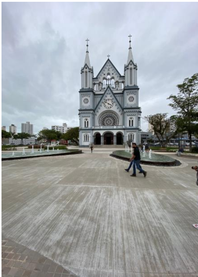
FIGURA 25 – Imagem de obra finalizada (1)
