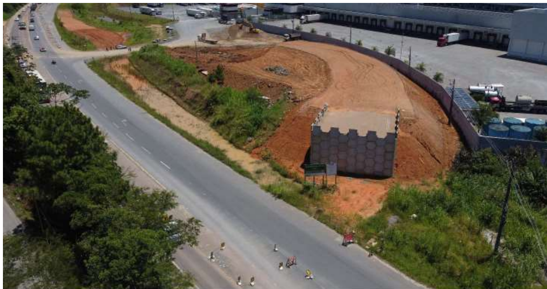
Figura 11. Imagem do viaduto em construção no km 45 – Blumenau/SC – Lote 03:
