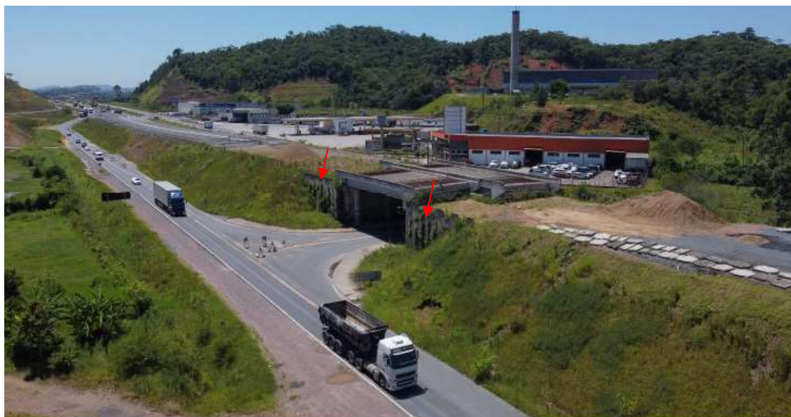
Figura 10. Viaduto em execução no km 36,2– Gaspar/SC – Lote 02:
