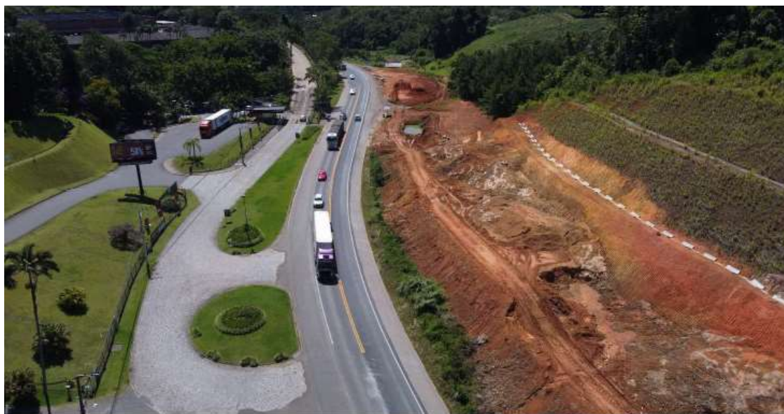
Figura 12. Imagem da terraplanagem e contenções de encostas no km 54 - Blumenau – Lote 03
