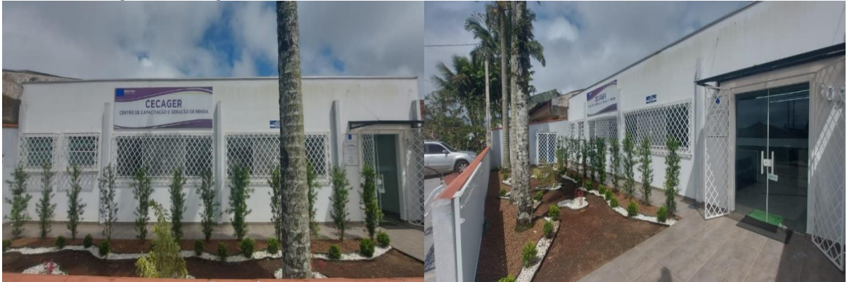
Figura 1. Vista do Centro de Capacitação e Geração de Renda - (CECAGER). Figura imagem frontal do centro e figura B, imagem lateralizada.
